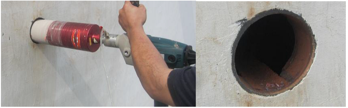
Borra i väggen, använd 108mm borrar bit.
