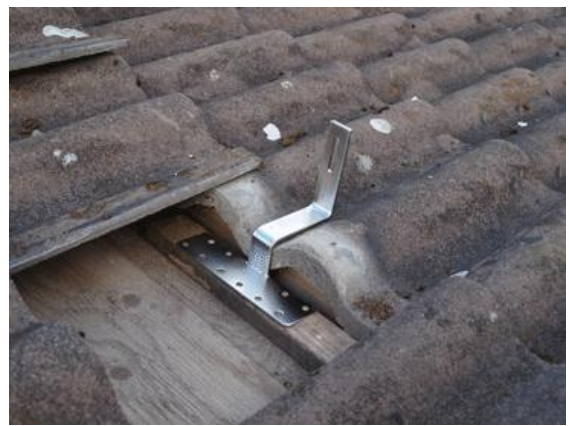
Monteringskrok, på tegeltak
