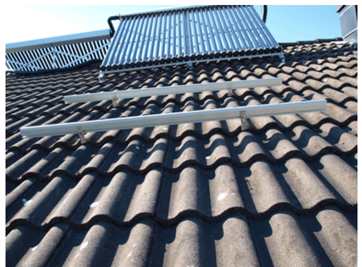
Monteringskrok, på tegeltak
