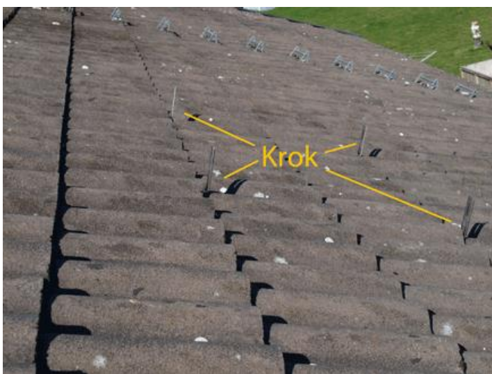
Monteringskrok, på tegeltak
